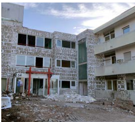
Rückbau des Thomashauses
