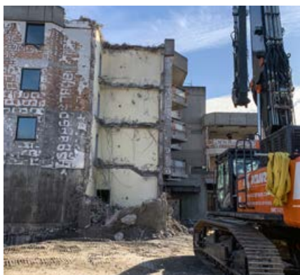
Bagger im Einsatz
