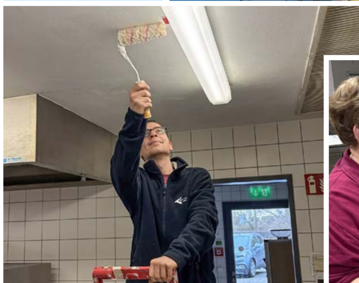
Auch die Küche bekam einen neuen Anstrich
