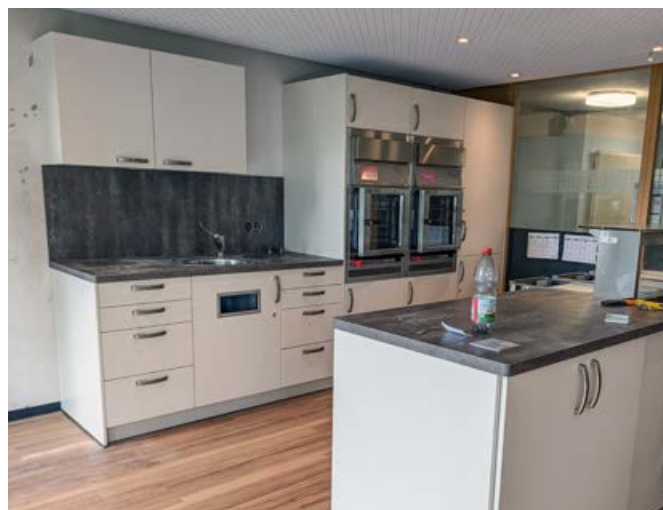
Umbau der Küchen in den B-Bereichen
